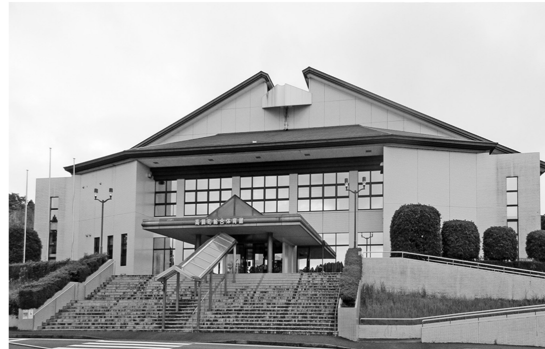
大規模改修工事が行われる高鍋町総合体育館
