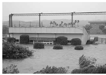
平成17年の台風14号の影響で水没した町営野球場。災害はいつ起こるか分からない
