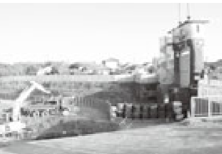
基礎工事中の宮田川水門
