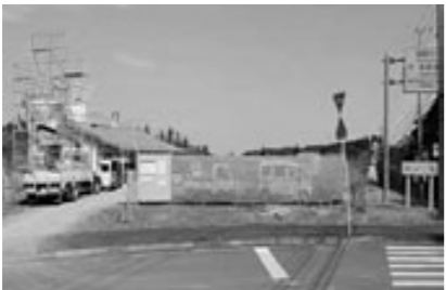
高鍋温泉入り口に建設中の加工施設
