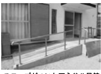
スロープがついた下永谷公民館
