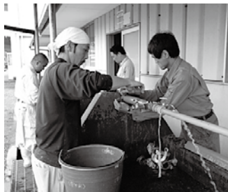
丁寧に補修を行う高鍋町管工事事業組合の皆さん
