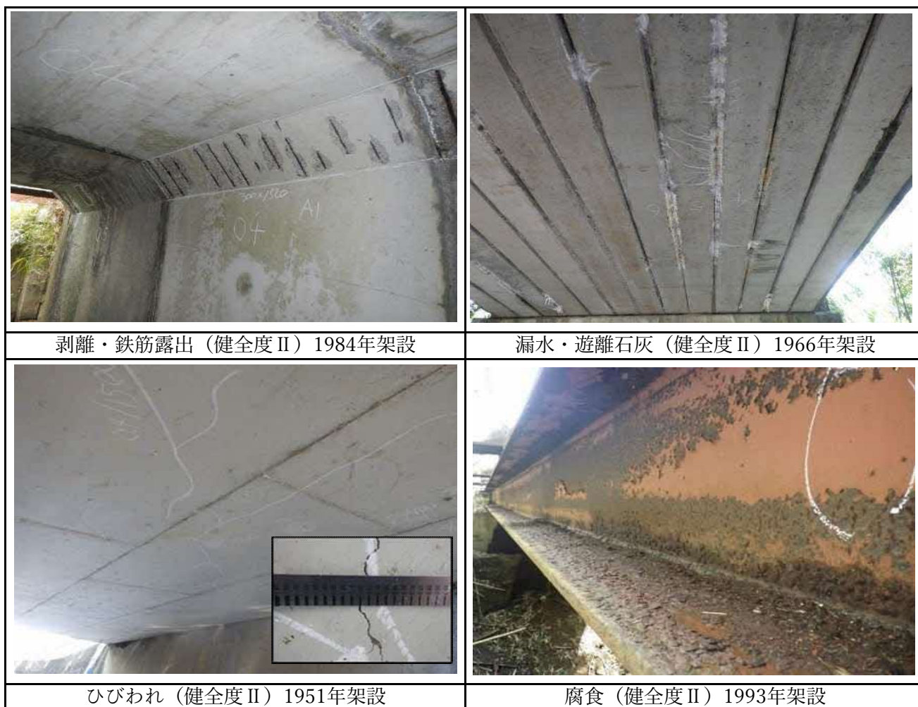
図 6 損傷状況
