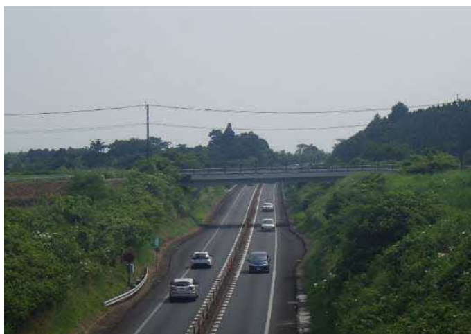
図 10 道路を跨ぐ橋梁の例（高鍋町 牧内第三橋）
