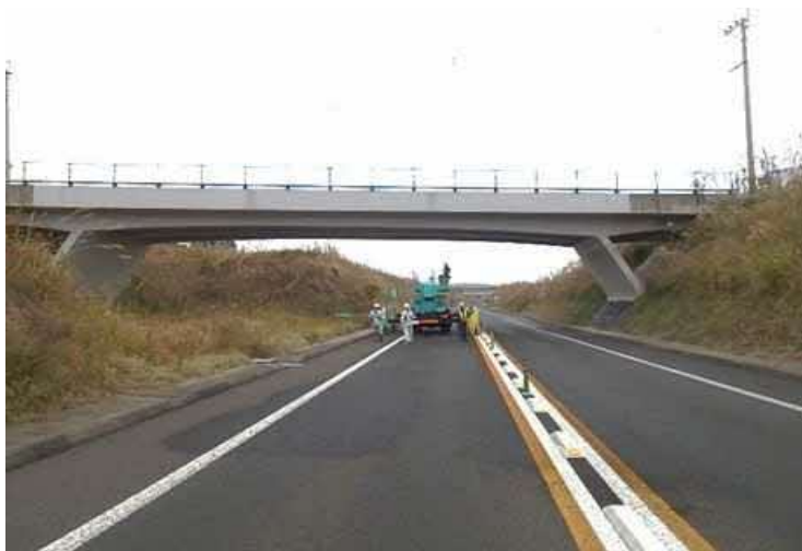
図 10 道路を跨ぐ橋梁の例（高鍋町管理 牧内第三橋）
