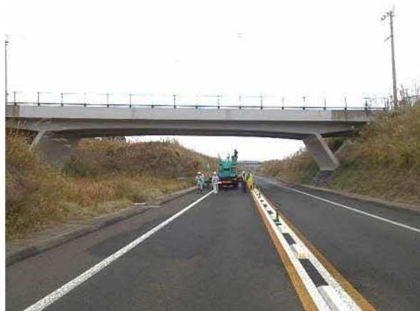
図 10 道路を跨ぐ橋梁の例（高鍋町管理 牧内第三橋）
