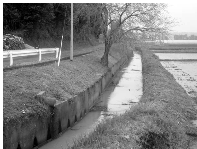
羽根田排水路嵩上・浚渫工事箇所
