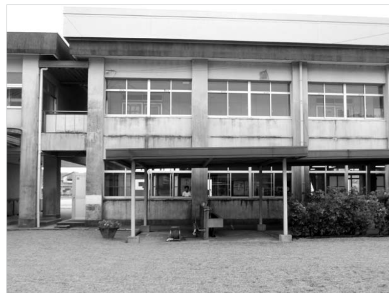
中学校外壁改修
