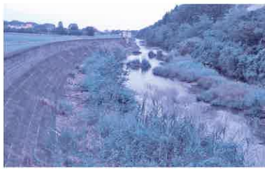
急がれる宮田川圏域河川整備
