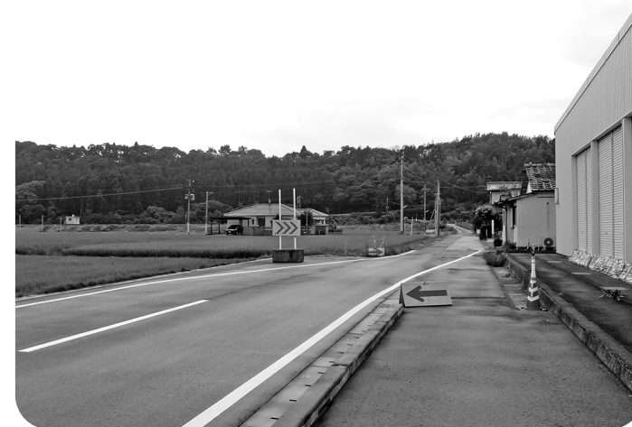
道路改良工事を待つ「天神鶴・茂広毛平付線」
