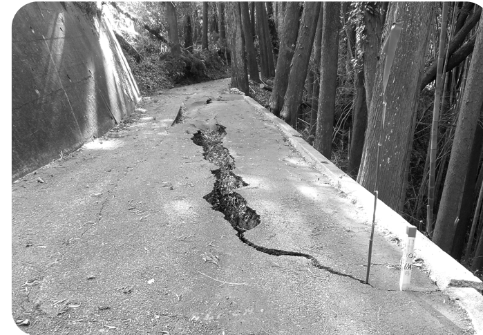
改修工事を待つ町道「池端・計塚線」
