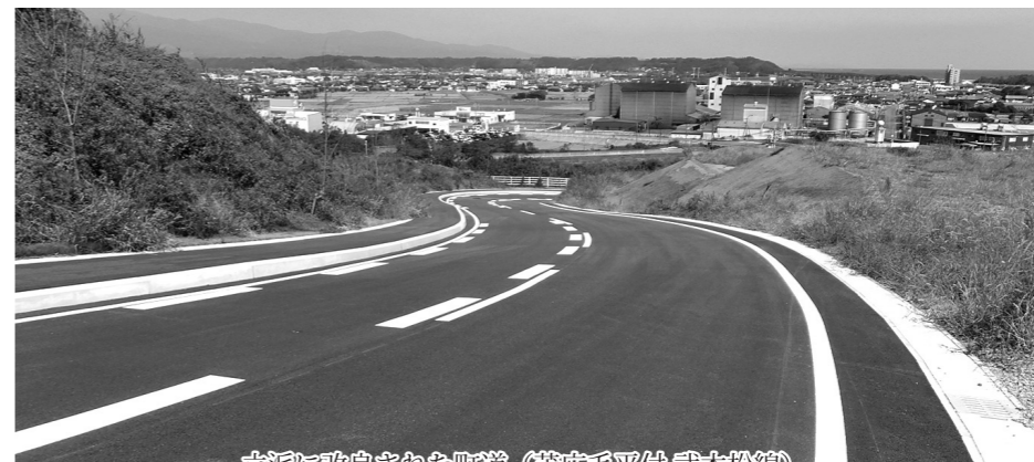
立派に改良された町道（茂広毛平付式本松線）
