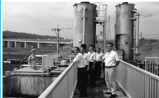
「竹鳩浄水場施設調査」
