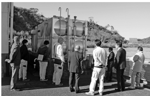
撤去が決まった受水槽
