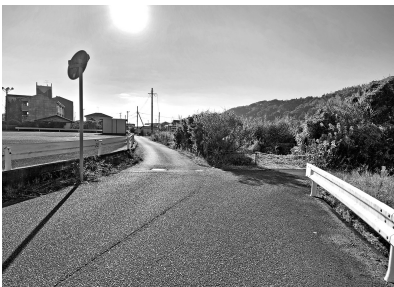
道路整備が待たれる樋渡1線
