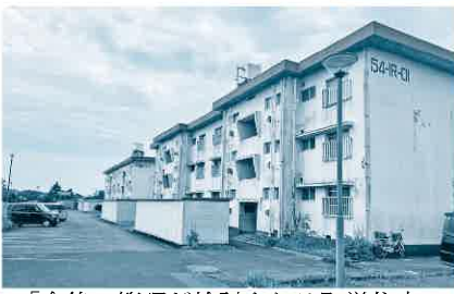
「今後の管理が検討される町営住宅」
