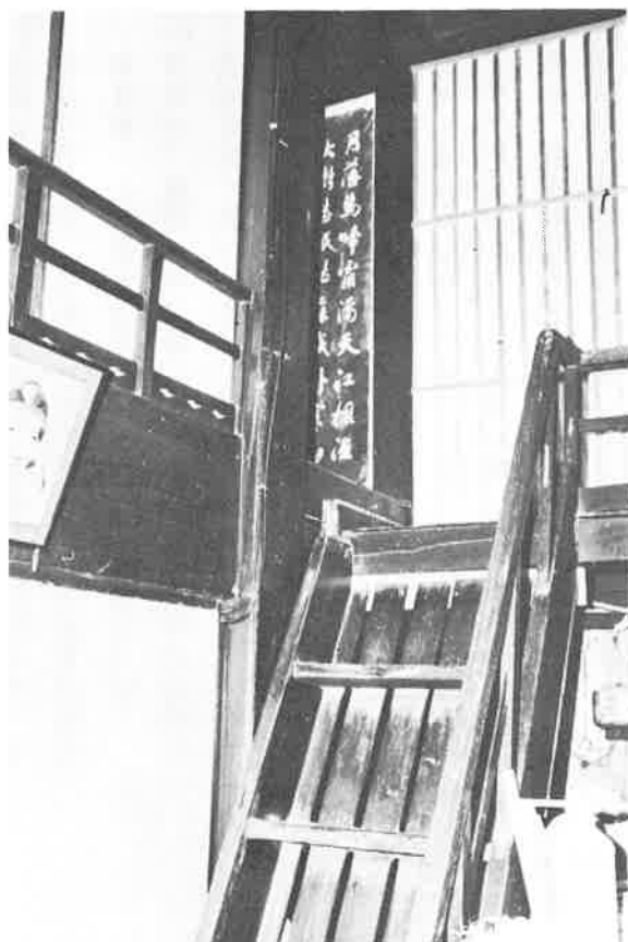
▶ 階段と手すり
