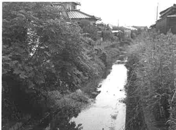
西小北側の排水路
