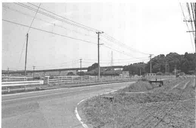
老瀬から宿の坂を望む。（老瀬ポンプ場付近）
