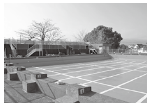
改修後のプール
