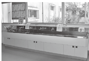
新設された手洗い場
