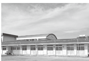
改修後の部室棟
