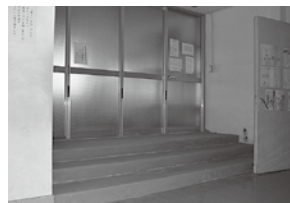
給食コンテナ室階段
